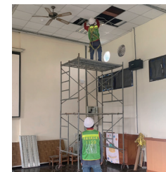
瑞峰國小校園 LED 燈具施工情形
